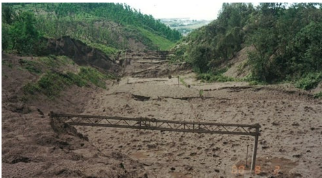
2000 年噴火当時の階段状に破壊された旧国道
