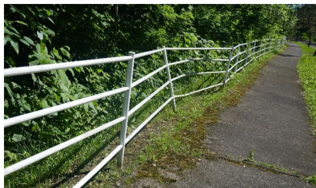
地面が押し縮められ、折れ曲がってしまった散策路脇の柵
