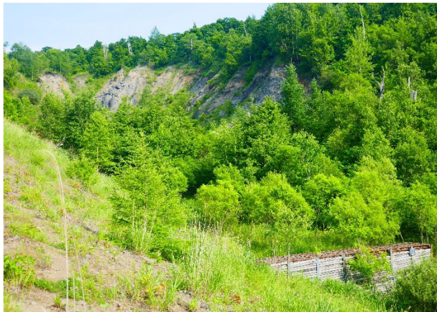
熱泥流発生地と砂防堰堤
