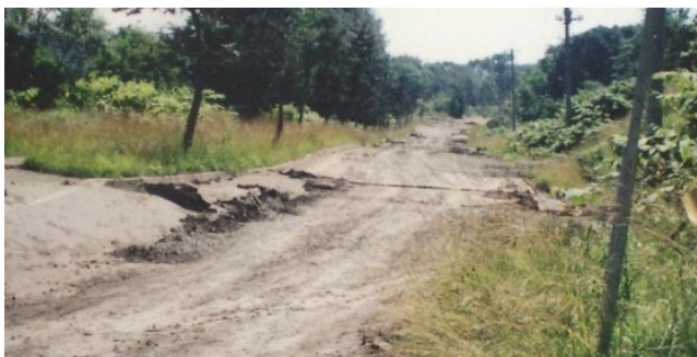
地面が押し縮められ波打つ旧町道
