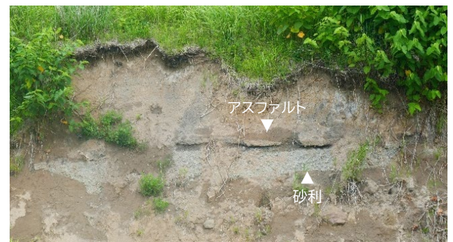
火口壁に見える旧町道の断面
