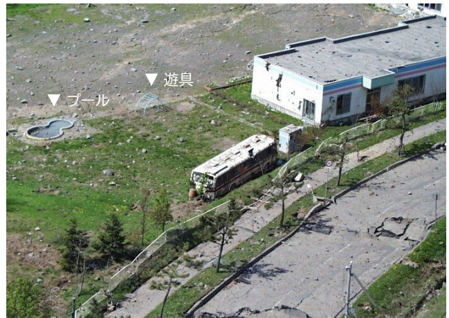
噴石によって破壊された旧とうやこ幼稚園の天井 (提供写真:宇井忠英)
