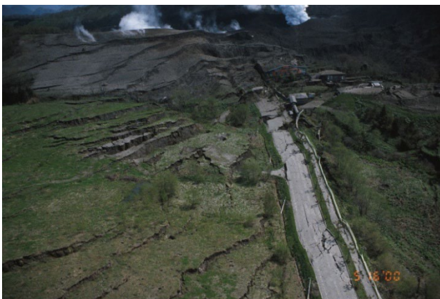
断層の形成により破壊された道路 (提供写真:宇井忠英)
