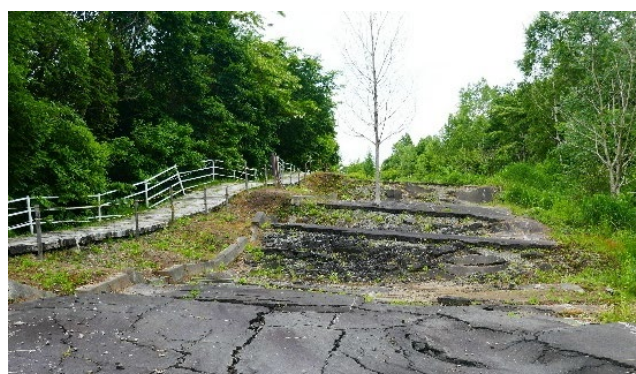
階段状に落ち込んだ旧町道
