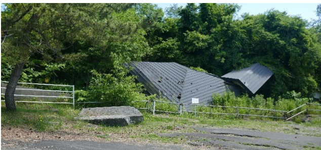
破壊された住宅
