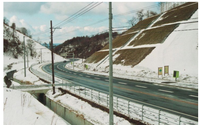
2000年噴火前の国道と電柱
