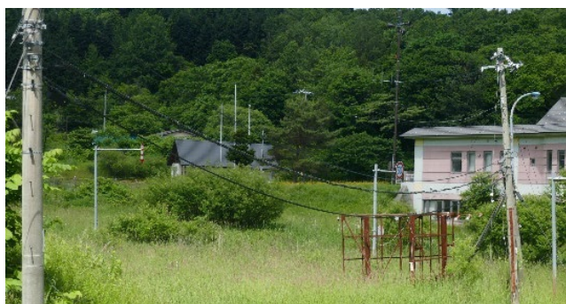
地面が押し縮められ、たるんでしまった電線
