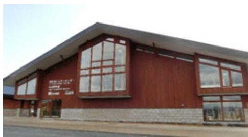
洞爺湖ビジターセンター・火山科学館 （洞爺湖町洞爺湖温泉 142 番地）
